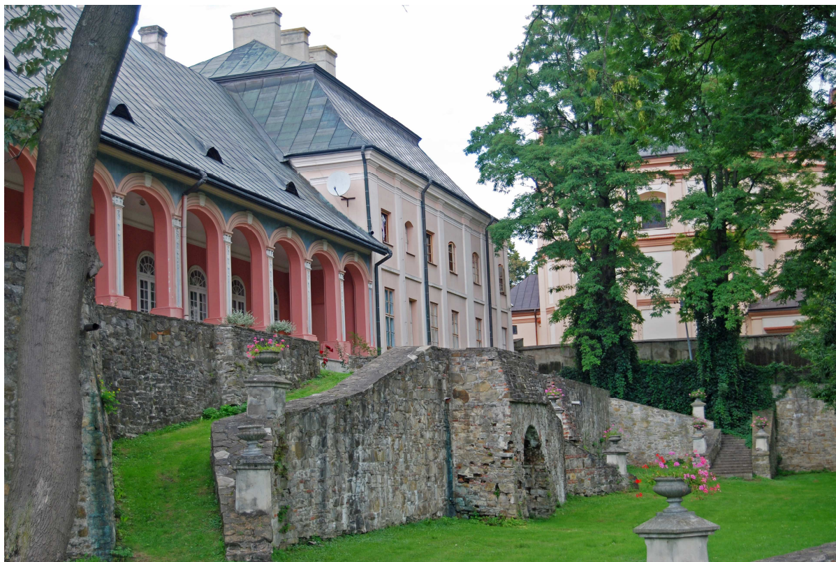
Fot. 5. Widok na galerię z podcieniami pałacu w Boguchwale 18
