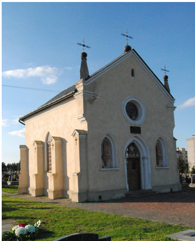
Fot. 24. Kaplica cmentarna w Boguchwale 34
