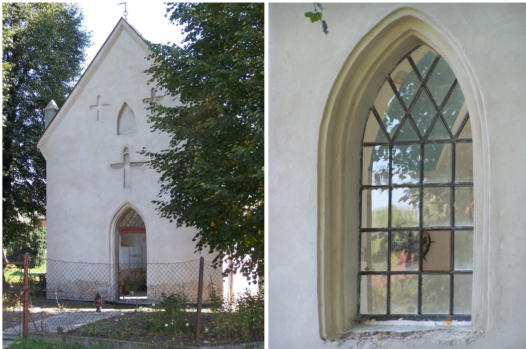
Fot. 17, 18. Kaplica Św. Marka w Zgłobniu 29
