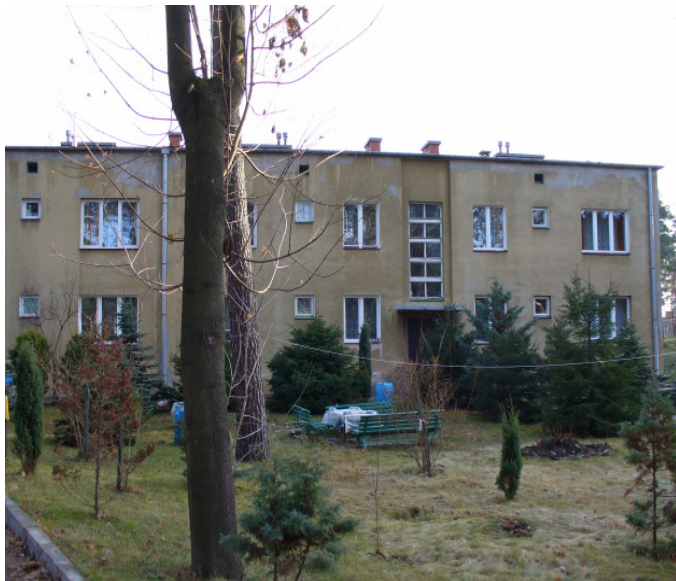
11. WNO „Nitroza” – osiedle mieszkaniowe, blok 2 klatkowy
