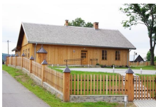
Szkoła Ludowa po remoncie
