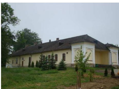
Dwór Stojowskich po remoncie konstrukcji dachowej
