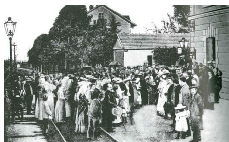
Stacja kolejowa dnia 08.09.1903 r.
