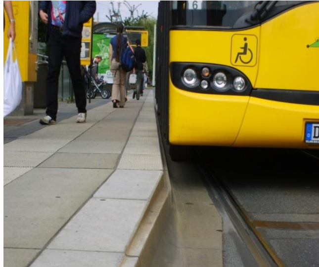
Rys. 8.6.1. Zalecane ukształtowanie krawędzi peronowej. Źródło: materiały własne TRAKO.
