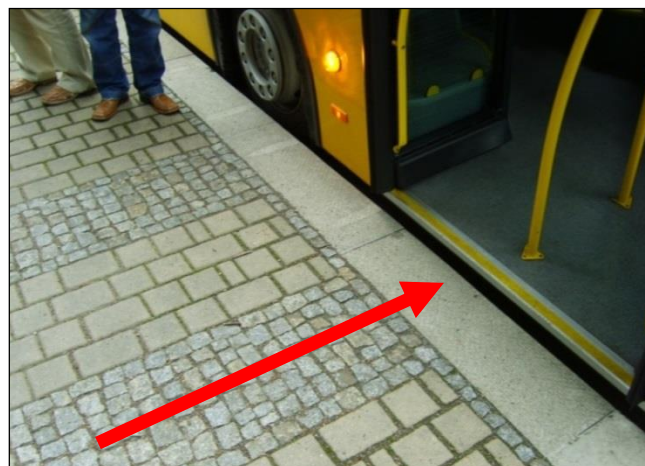
Rys. 8.6.2. Strefa wejściowa – inny rodzaj nawierzchni naprzeciwko pierwszych drzwi autobusu. Źródło: materiały własne TRAKO.
