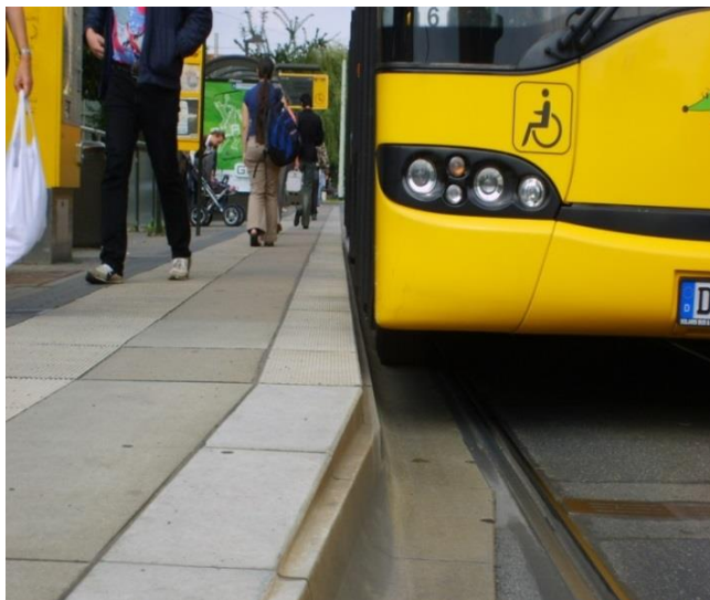
Rys. 8.6.1. Zalecane ukształtowanie krawędzi peronowej. Źródło: materiały własne TRAKO.
