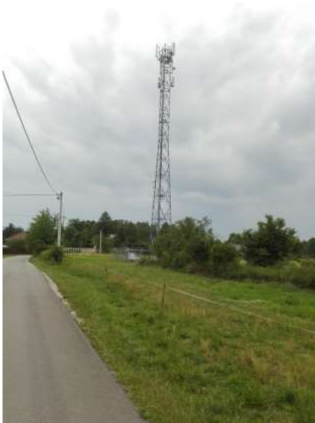
Stacja bazowa telefonii komórkowej w m. Krzaki.
