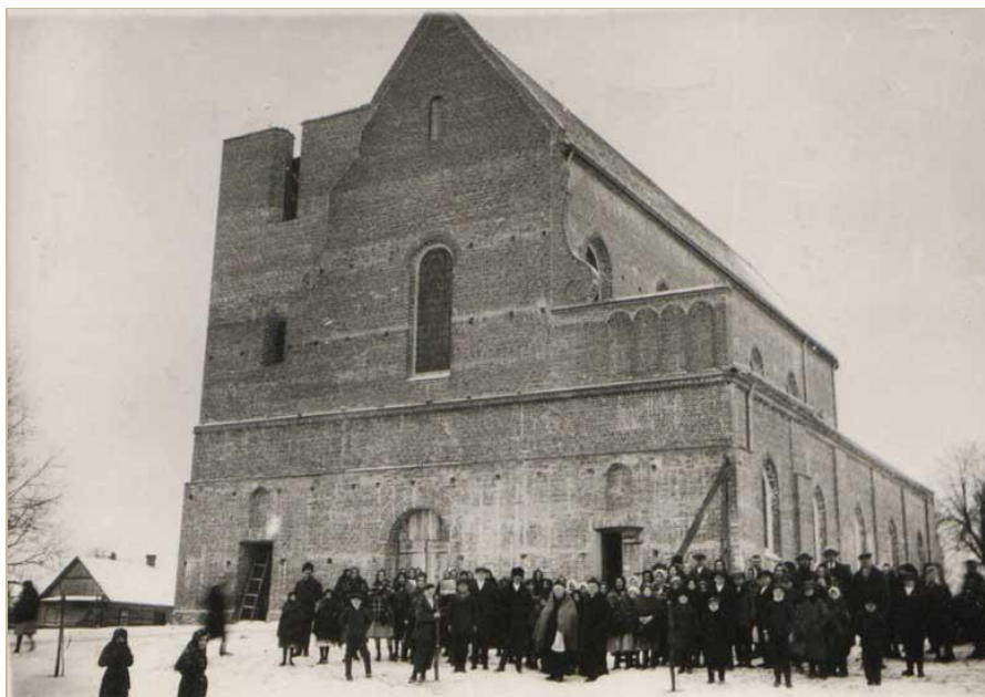
Obecny kościół paraf. w Pysznicy w budowie, fot. arch. w zbiorach SWAL Pysznica
