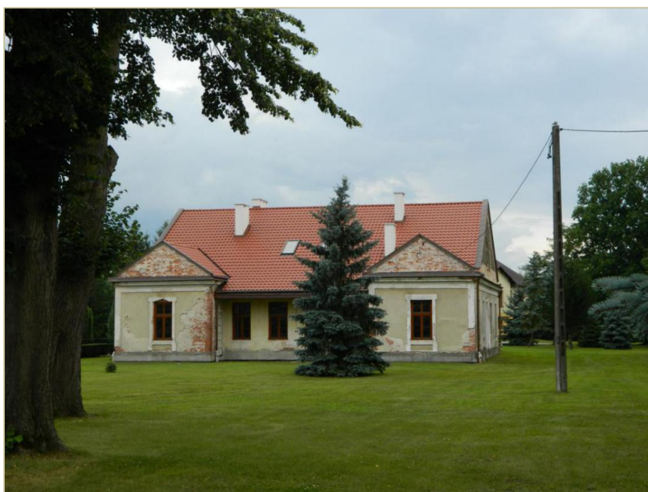
Pysznica – Budynek plebanii wzniesionej w 1909 roku przez ks. I. Pyzika, fot. P. Błasiak, 2010
