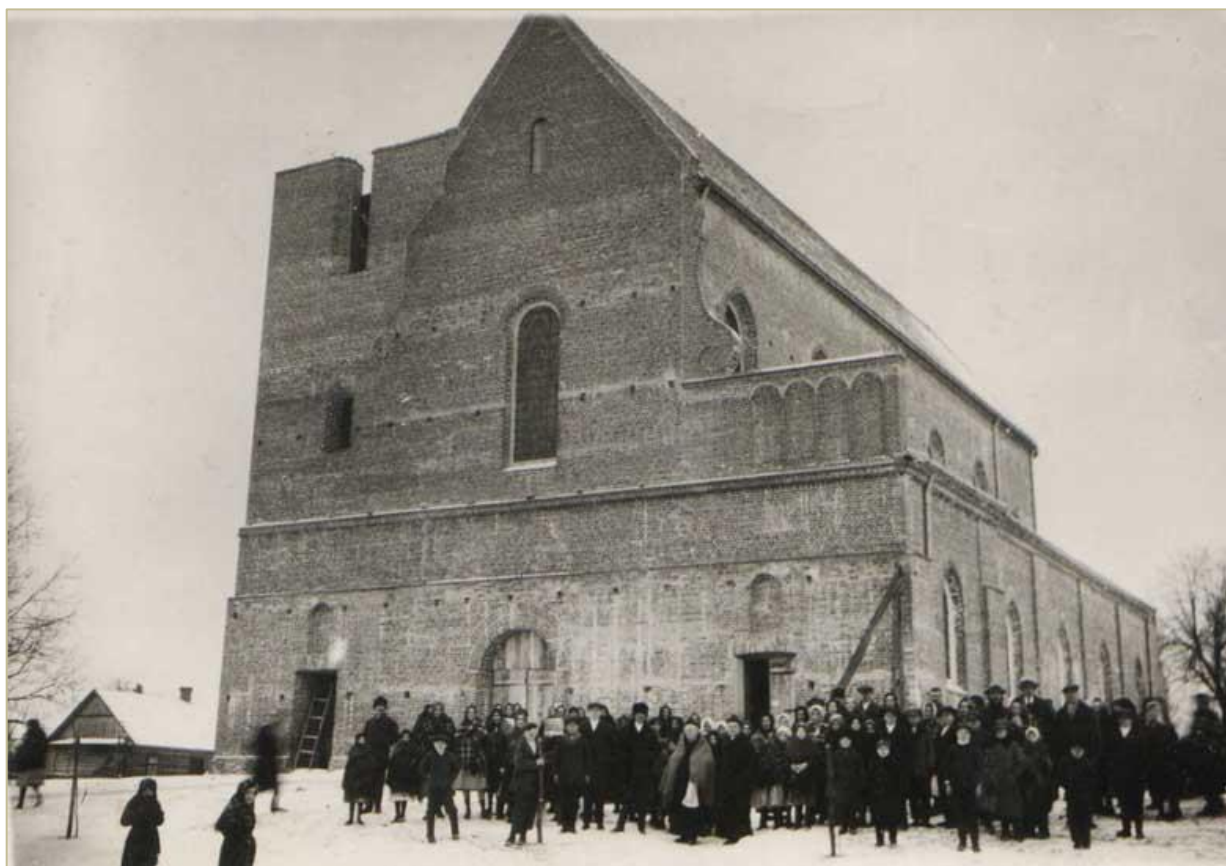
Obecny kościół paraf. w Pyszniczy w budowie, fot. arch. w zbiorach SWAL Pysznicza
