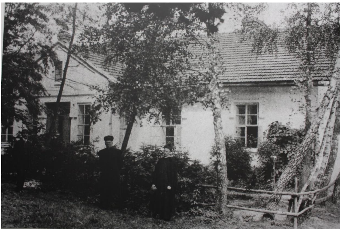
Wielopole Skrzyńskie, Budynek plebanii, lata 20. XX w.
