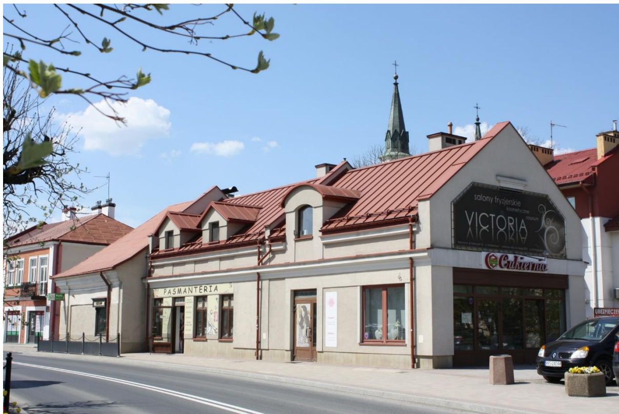
Ropczyce, Budynek dawnej poczty konnej, ul. Mickiewicza 1-6
