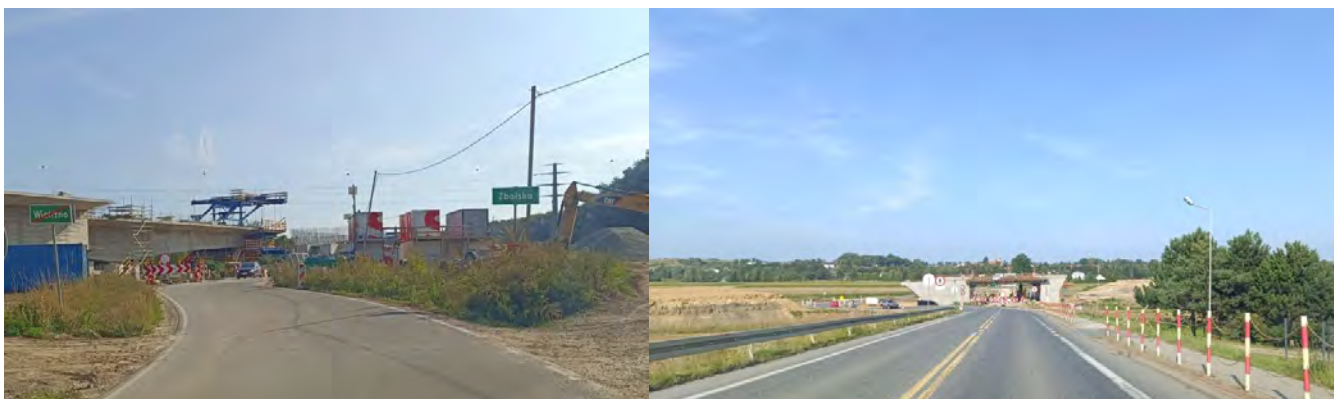
Rysunek 5. Budowa trasy S-19
